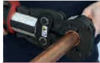
3. Effectuer le raccordement à l'aide de la sertisseuse.
