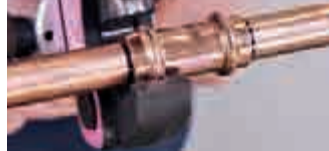
10. Effectuez le sertissage à l'aide de l'outil approuvé. Ne sertir qu'une seule fois
